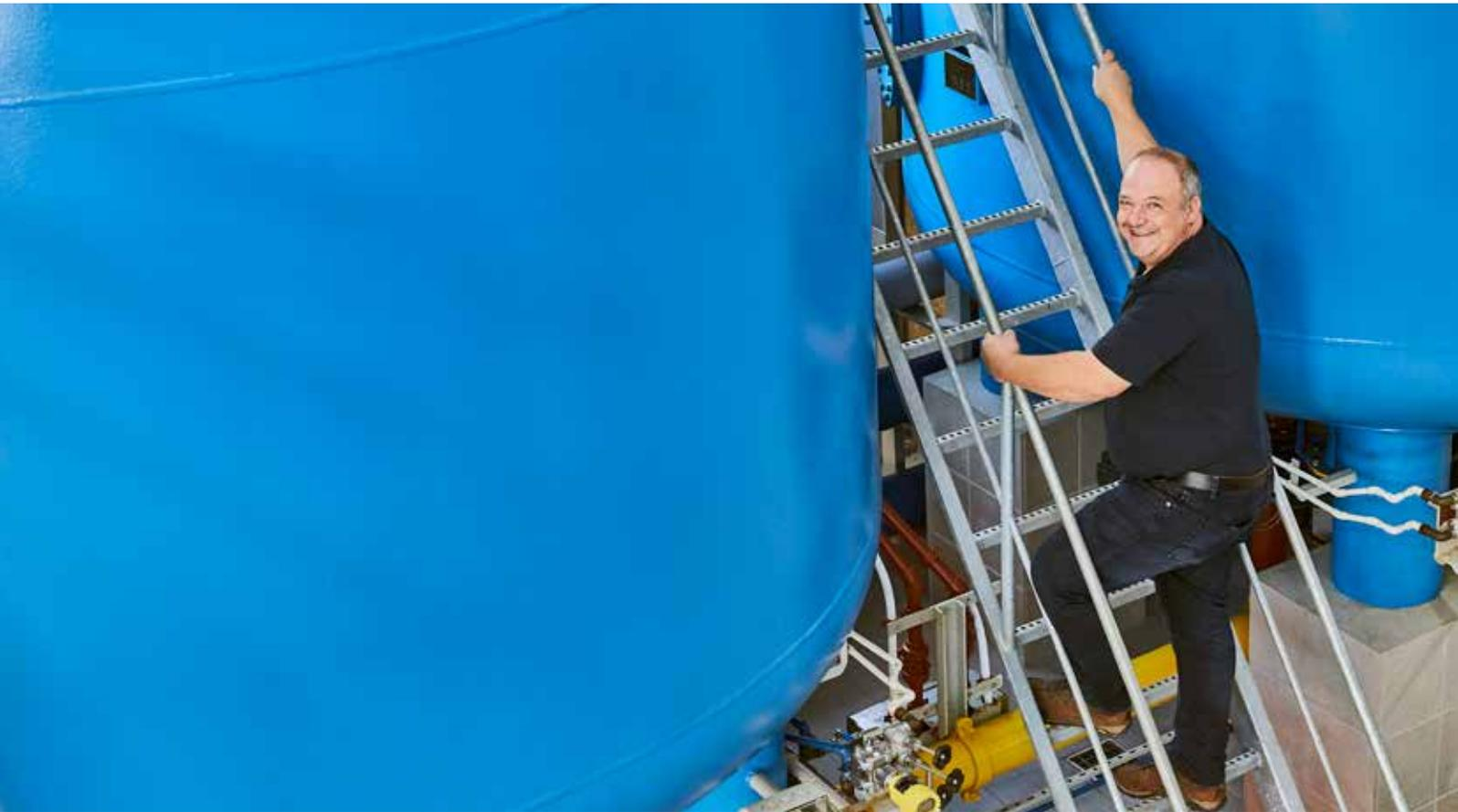
In Wassertanks werden Eisen und Mangan aus dem Trinkwasser herausgefiltert.
